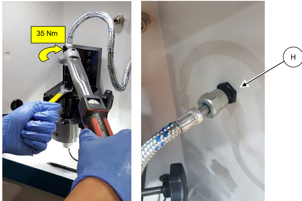
Figura 4.6 Serraggio della tubazione alta pressione
