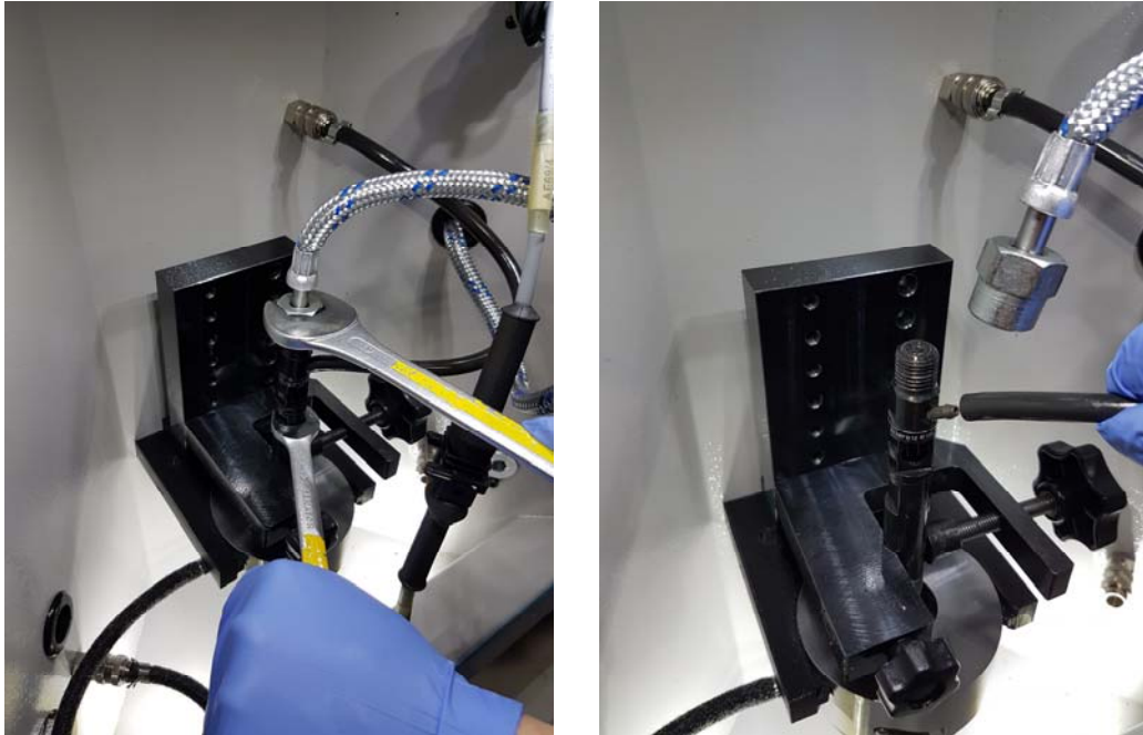
Figura 4.13 Rimozione dei collegamenti idraulici
